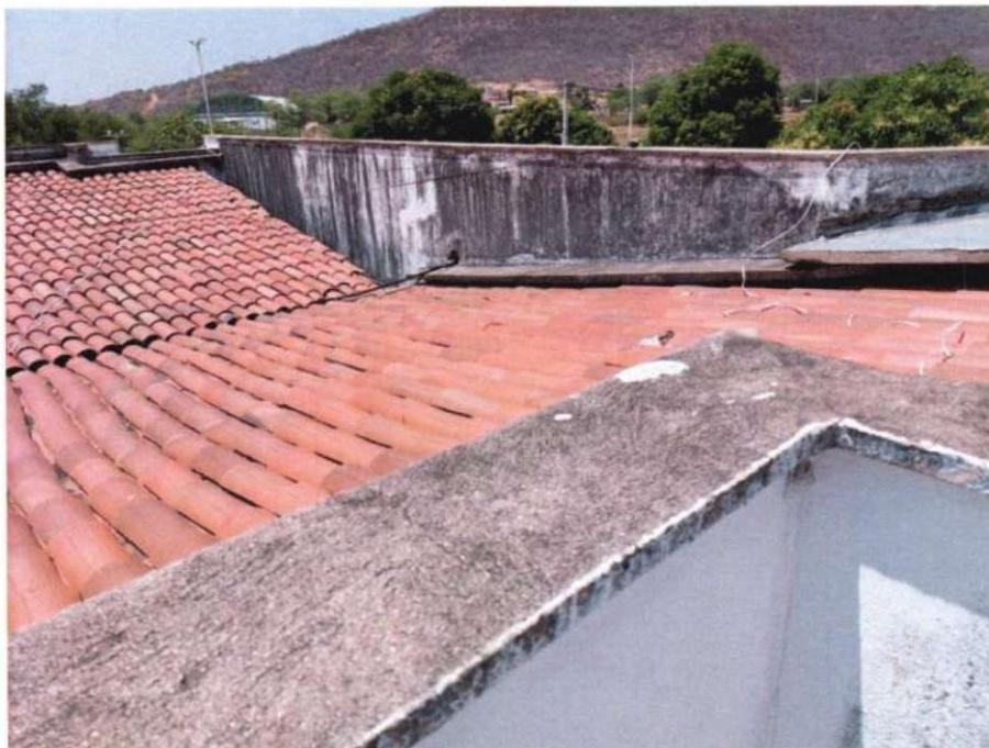
Foto 15: Detalhe da calha a ser impermeabilizada;
