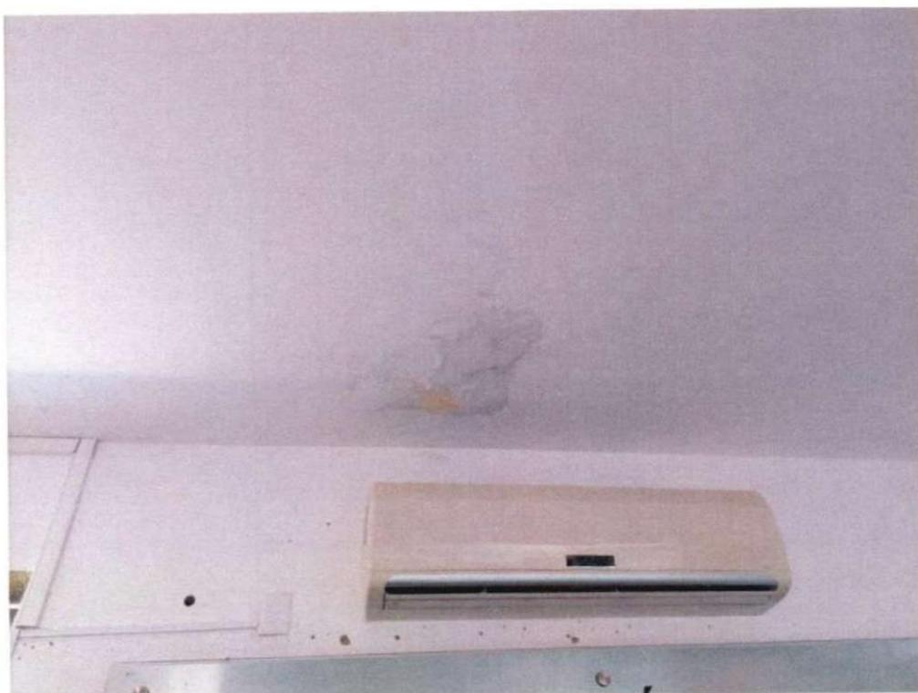
Foto 04: Detalhe da umidade no teto;
