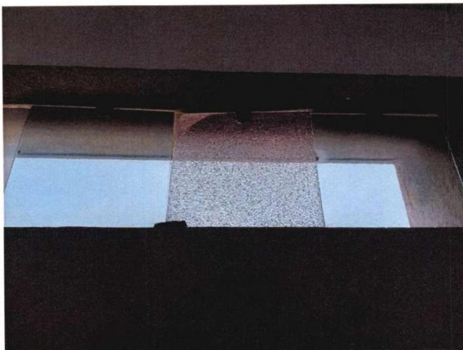
Foto 08: Detalhe do vidro a ser trocado;
