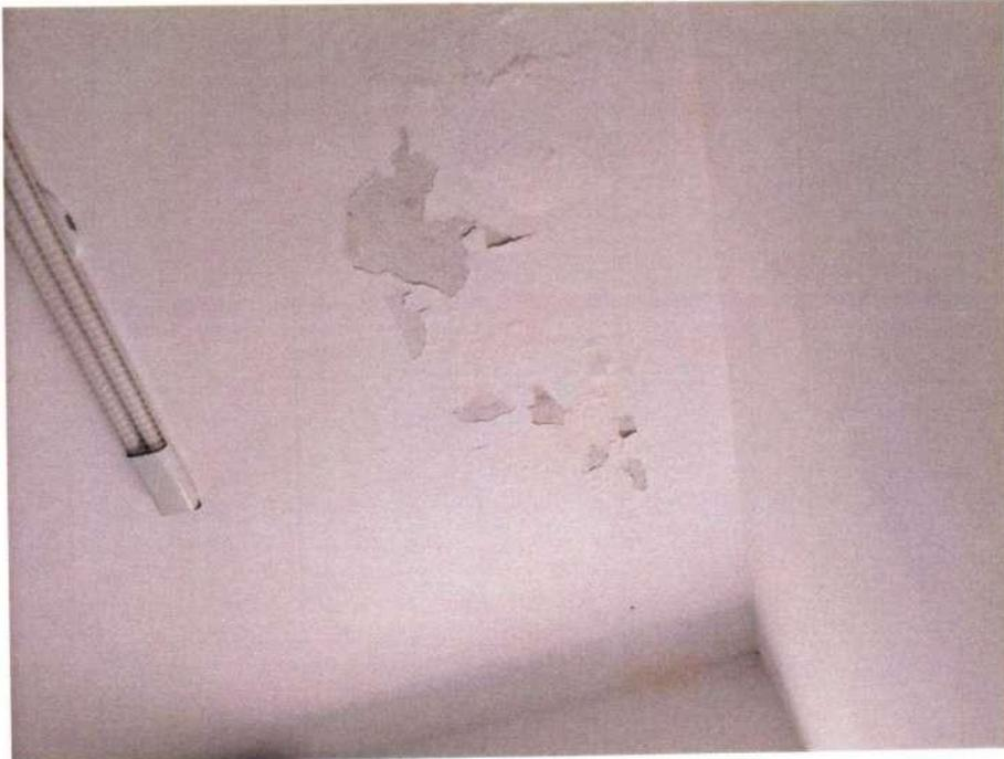
Foto 05: Detalhe da umidade no teto;
