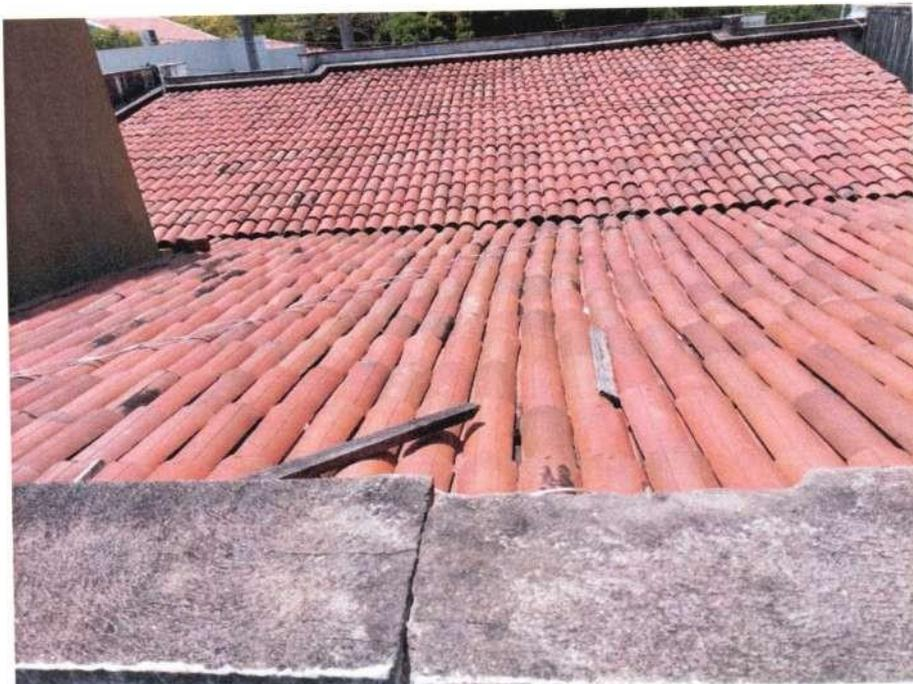
Foto 06: Detalhe da cobertura de telha cerâmica;
